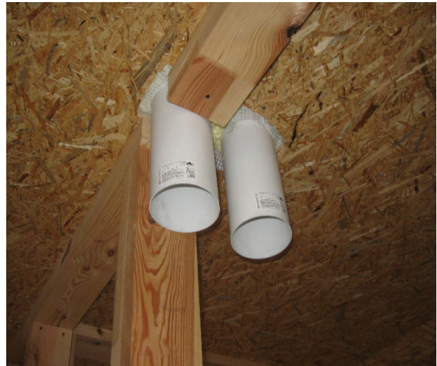
Монтаж системи вентиляції
