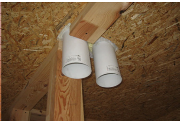
Монтаж системи вентиляції
