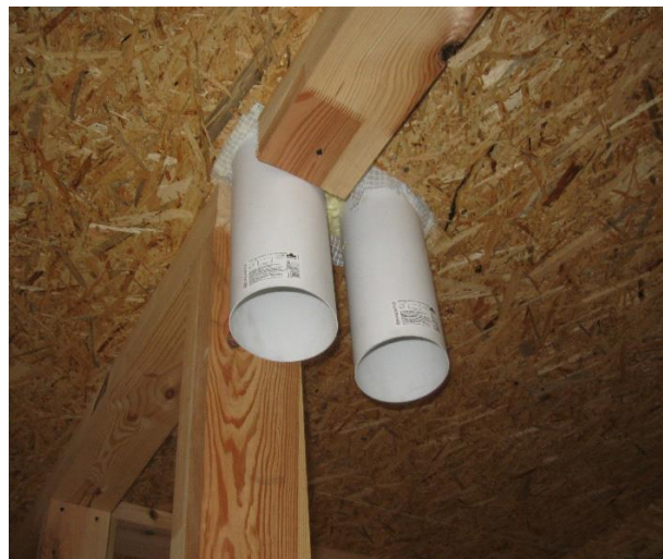
Монтаж системи вентиляції
